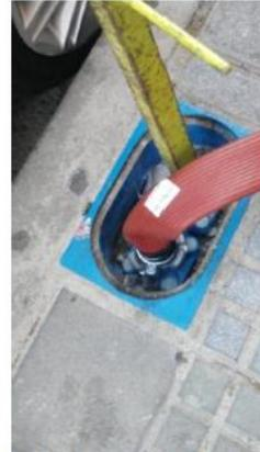
Detalle de punto de conexión rápida para hidrolimpiador
